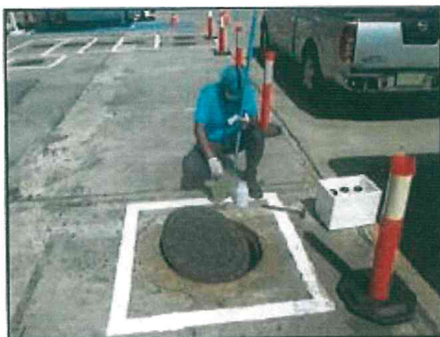
รูปที่ 81 โครงการออกแบบระบบบำบัดน้ำเสียให้มีฝาเปิด 2 ฝา ต่อถังเพื่ออำนวยความสะดวกในการ บำรุงรักษาและทำความสะอาด
