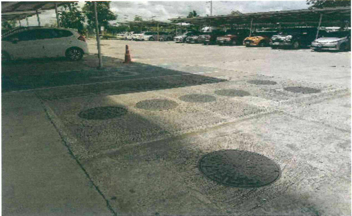
รูปที่ 74 โครงการจัดให้มีระบบบำบัดน้ำเสียชนิดเติมอากาศแบบมีตัวกลางยัดเกาะ รองรับน้ำเสียได้ 160 ลบ.ม./วัน จำนวน 1 ชุด ติดตั้งไว้ด้านหลังอาคารโรงพยาบาล
